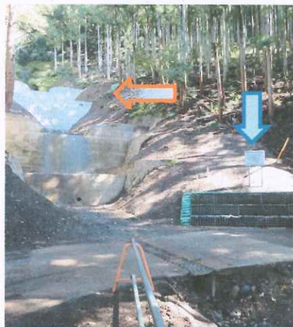
洞の沢砂防ダム、石籠の土砂止め 10/2撮影
