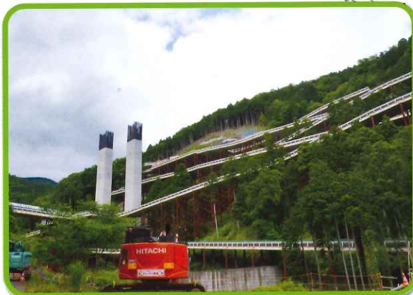
尺里川橋・橋脚が完成し橋桁の工事へ進む
