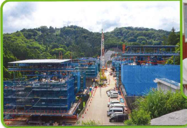
滝沢川橋・橋脚が完成し橋桁をつなぐ工事を実施
