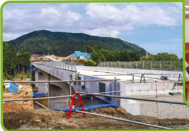
柳橋・橋桁がつながり舗装工事の実施に入る
