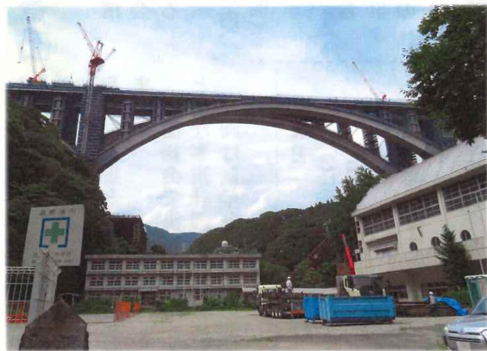
清水地区の避難場所となっている旧小中学校
